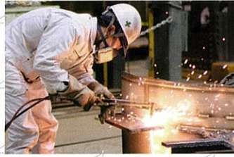
東海テクノ 〈プラント設備及び産業機械の設計・製作・据付〉
