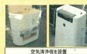
空気清浄機を設置
