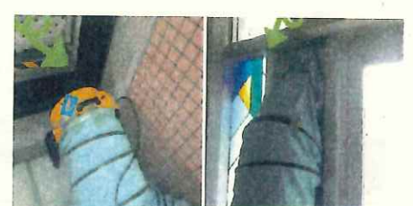
内装工事において、送風機及び冷却器を使った換気を実施
