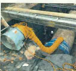
送風機により通気性を確保するとともに、ドライミスト発生装置等も併用
